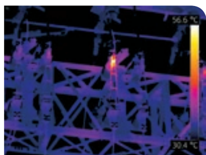
Przegrzewający się wyłącznik
