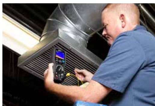
Termopara typu K do różnicowych pomiarów temperatury
